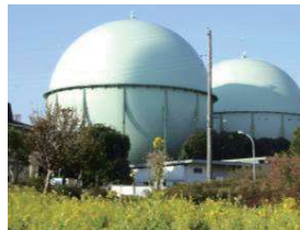
プラント設備
